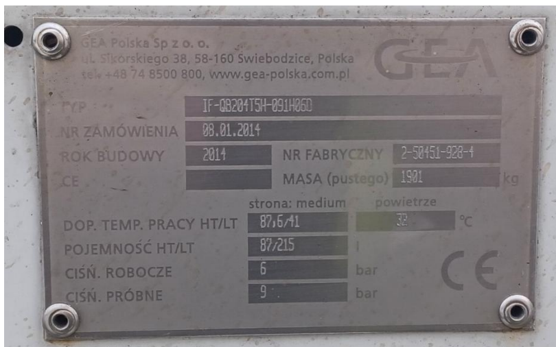
Rysunek 1. Tabliczka znamionowa istniejącej chłodnicy wentylatorowej.
